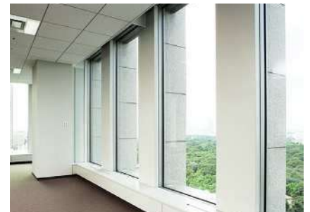
外装デザインに施された縦格子 Vertical grating used for the exterior design
